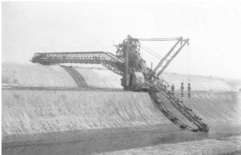
De excavateur graaft het kanaal uit in 1932
